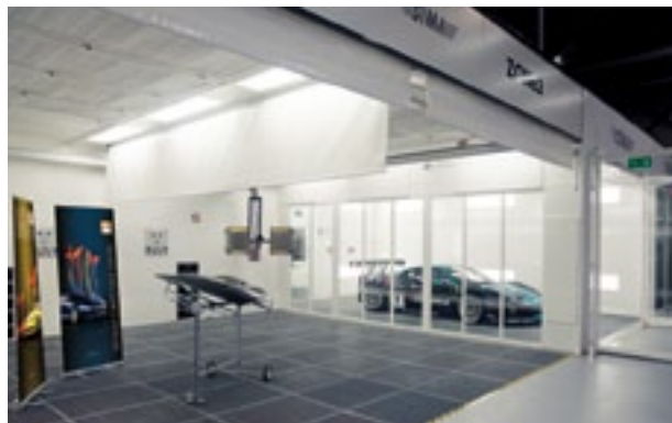
A Bornemben lévő tréning központ sztandardokat állít fel Európa szerte, az óránként hétszer teljes légcserét biztosító szellőztető rendszertől a biztonsági üvegen és a hab permetező rendszeren át az összetett munkaállomások elektromos biztonsági berendezéséig.
